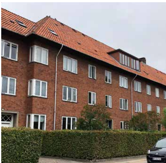
En del af ejendommen set fra gaden
