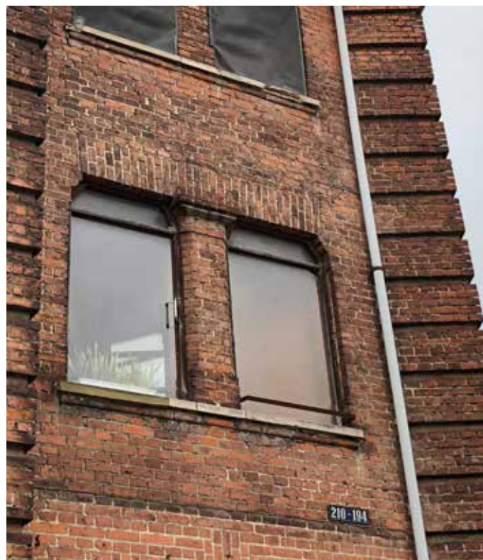
Facader omfuges og sokkel istandsættes.
