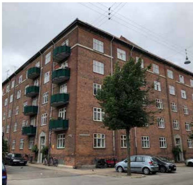
Utætte plastikvinduer udskiftes med støjrducerende træ/ træ-alu vinduer mod hhv gade/ gård. Alle sølbænke udskiftes.
