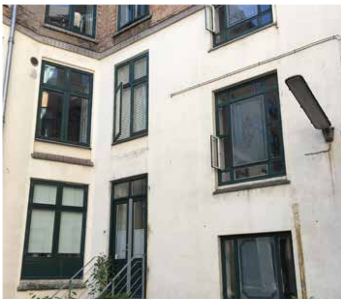
Gavle og underfacader mod gård efterisoleres
