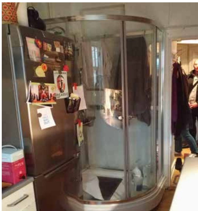
Lejlighederne mangler badeværelser. Der etableres 14 nye wc/bad.
