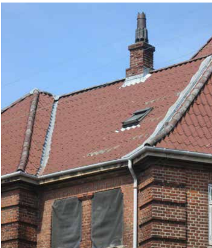
Tagbelægning udskiftes, derudover isoleres tag og kviste.
