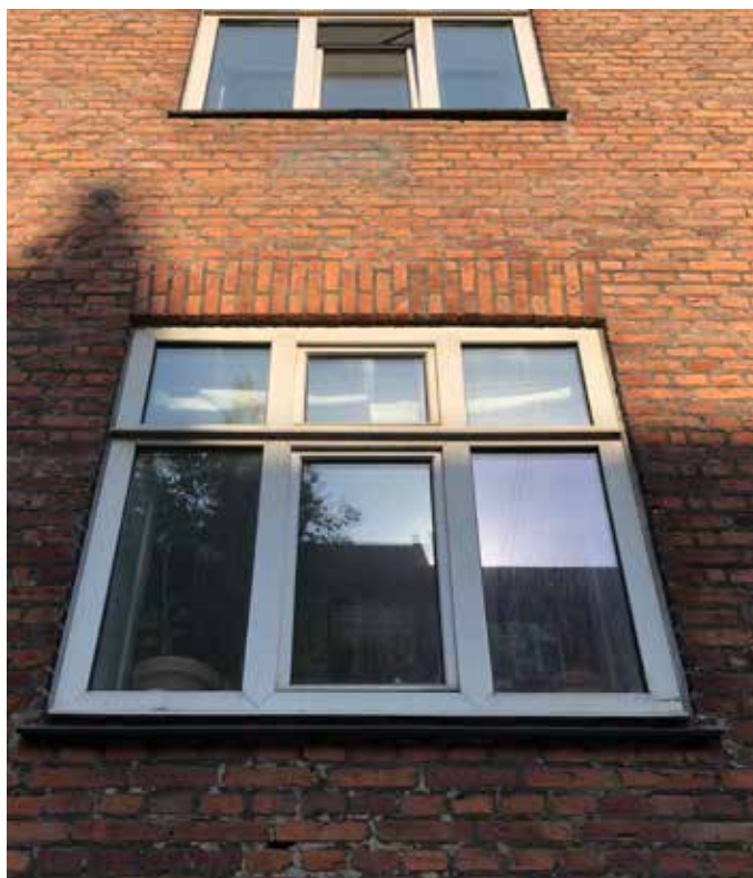
Utætte plastikvinduer udskiftes med støjrducerende træ/ træ-alu vinduer mod hhv gade/ gård. Alle sølbænke udskiftes.
