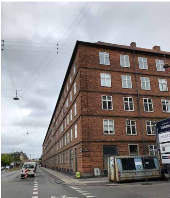
Vinduer uskiftes til støjrducerende og energibesparende vinduer.
