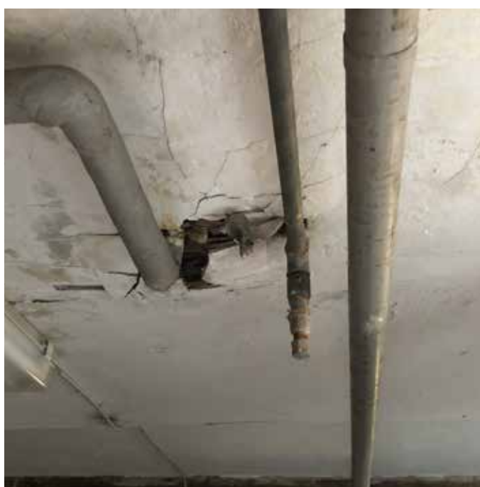
Etageadskillelser mod loft og kælder samt rør asbestsaneres.
