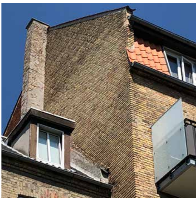
Gavl isoleres udvendigt. Vinduer mod gade/gård udskiftes.
