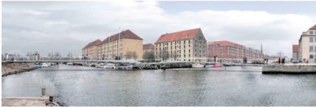
Kanalbro over Trangraven og Christianshavns Kanal.
