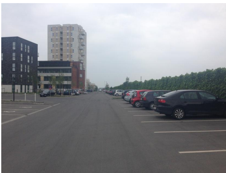
Manglende afmærkning til forskellige trafikanter. Krimsvej set mod syd - taget ud for Krimsvej 17-19
