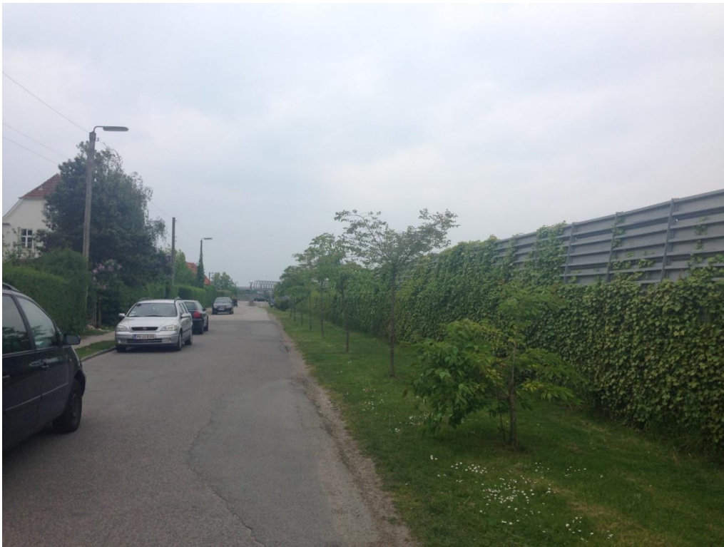
Tovelillevej set mod syd – taget ud for Tovelillevej 99
