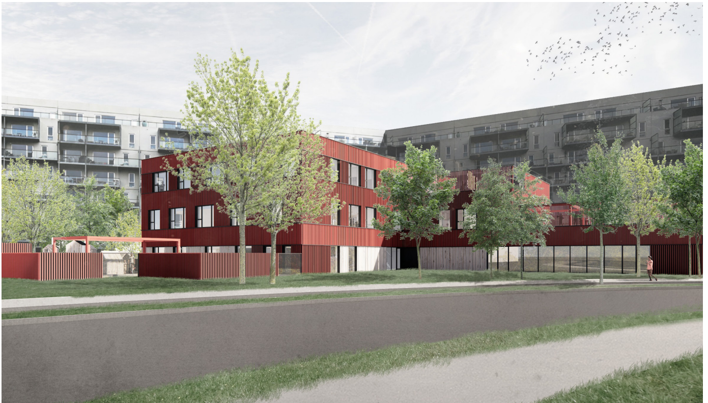
Visualisering, der viser et eksempel på et nybyggeri i delområde IIE i overensstemmelse med tillægget til lokalplanen. Nybyggeriet er set fra sydvest (Forlandet). Illustration: Rubow Arkitekter.
