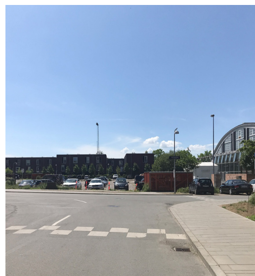
Billedet viser nordskellet af matr.nr. 650bt, Christianshavns Kvarter, hvor der etableres botilbud til unge med autisme. I baggrunden ses rækkehusbebyggelse.
