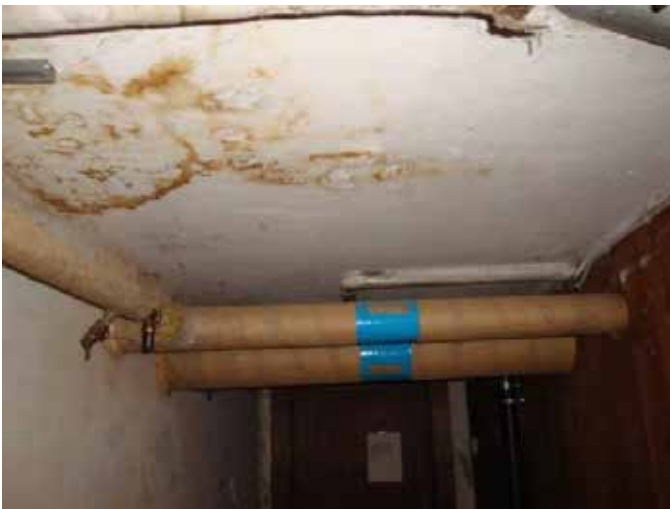
Etageadskillelse mod loft og kælder isoleres
