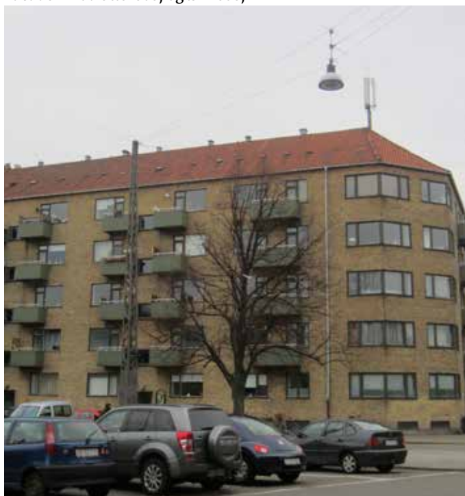
Facader mod Stærevej og Ørnevej
