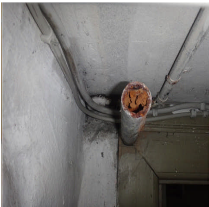
Tekniske installationer udskiftes og der skybrudssikres
