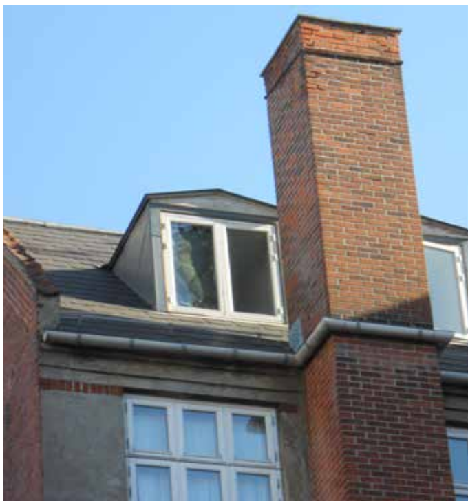
Tag og kviste udskiftes og isoleres
