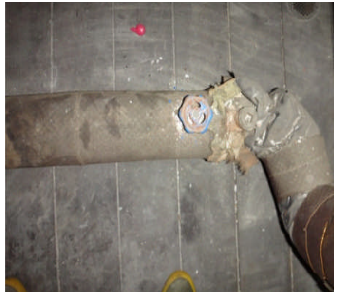
Vandinstallationer udskiftes til nye
