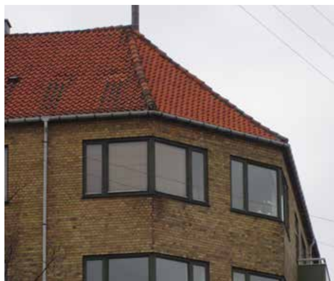
Tag udskiftes og isoleres
