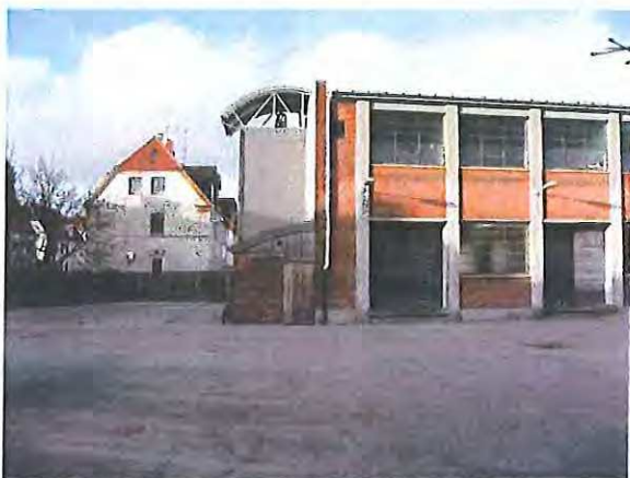
Mere moderne industribygning i vellykket typisk industriarkitektur, som står godt i arkitektur og proportioner til omgivende beboelse
