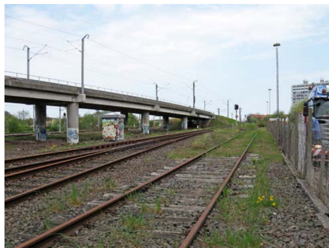
Jernbanespor og -bro nord for Beauvaisgrunden.
