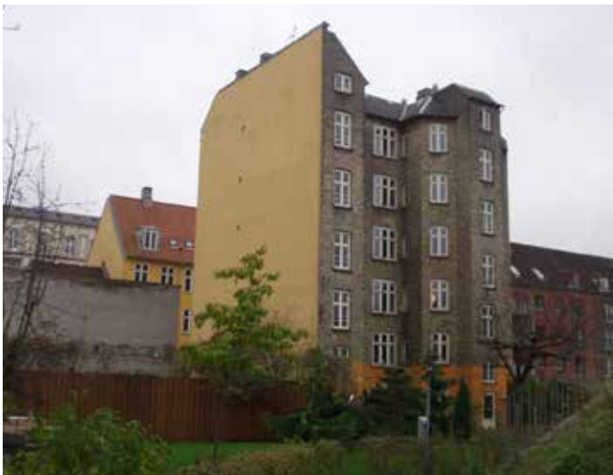
Baghuset får udskiftet vinduer og nyt tag
