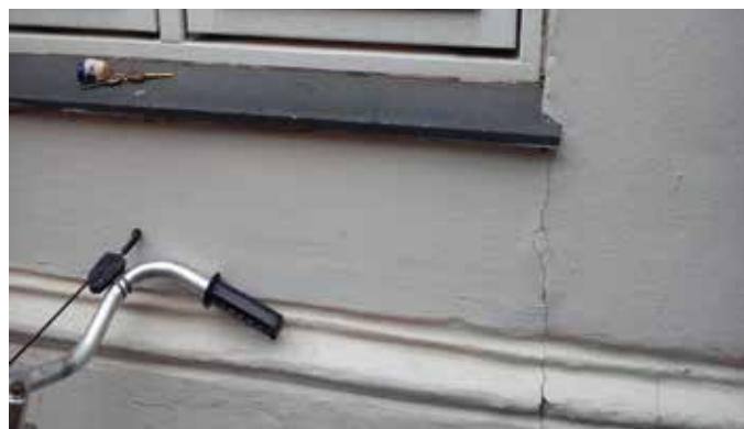
Revner i facader udbedres
