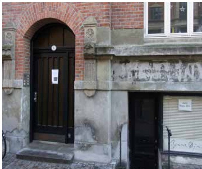
Underfacade, tydeligt påvirket af fugt, istandsættes
