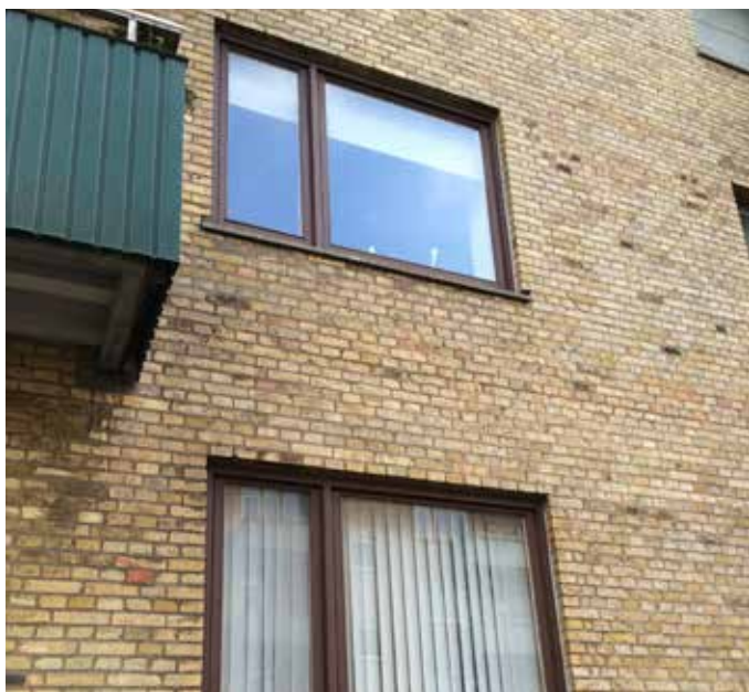
Vinduer udskiftes til vinduer, der lever op til 2020-krav Facade mod Frimestervej og Landsdommervej
