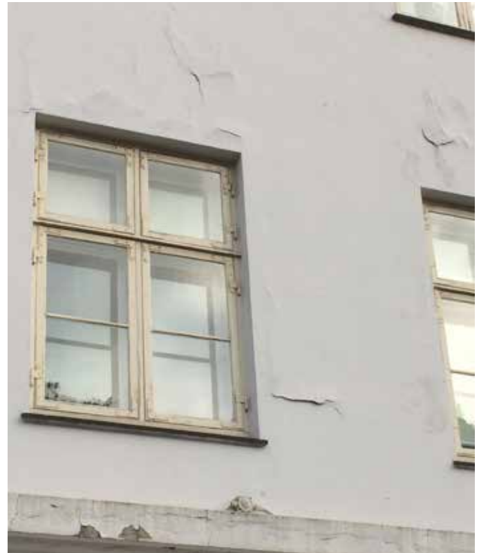
Pudsede facadefelter med afskallinger istandsættes
