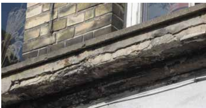
Gesimsbånd er nedslidte og istandsættes Gadefacade mod Landskronagade isoleres på den nederste del
