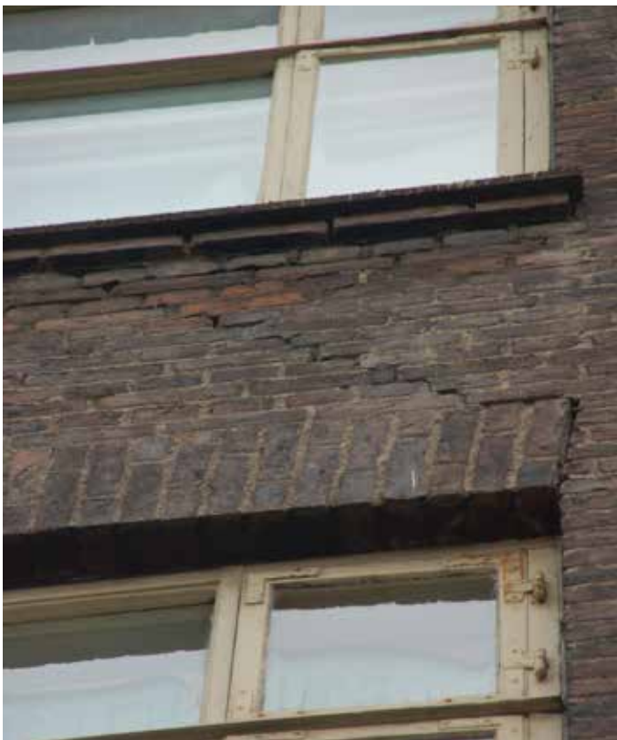
Vinduer mod gade udskiftes til nye trævinduer
