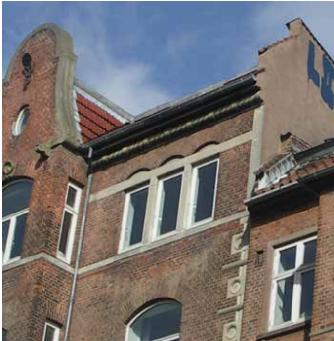
Etageadskillelse mod loft og kælder isoleres
