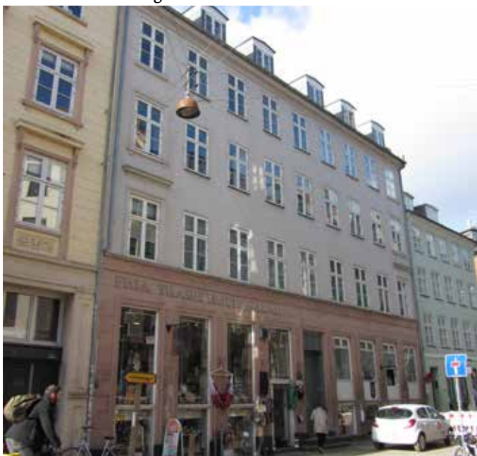
Facade mod Skindergade istandsættes
