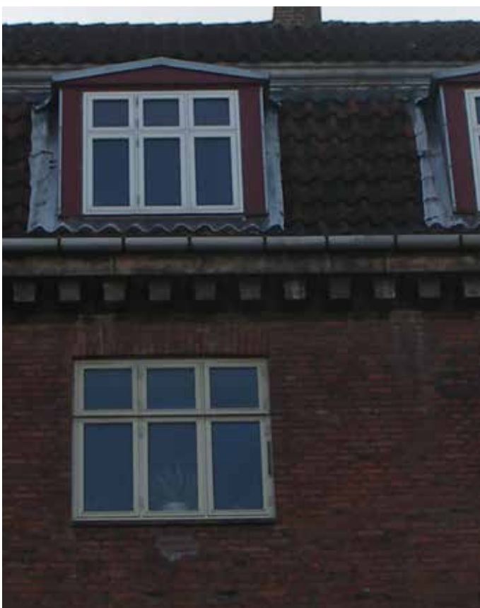
Reparation af tag og isolering
