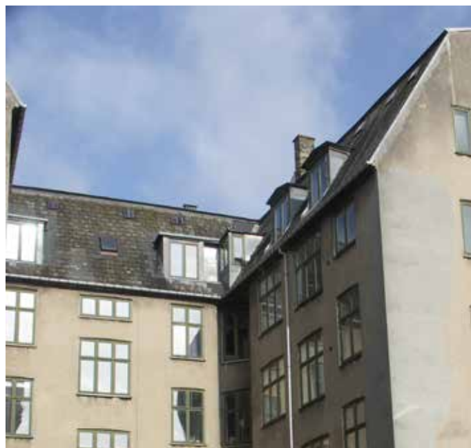
Tag er nedslidt og udskiftes
