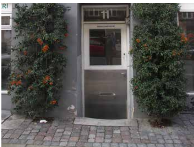
Ejendommen fugt- og skybrudssikres
