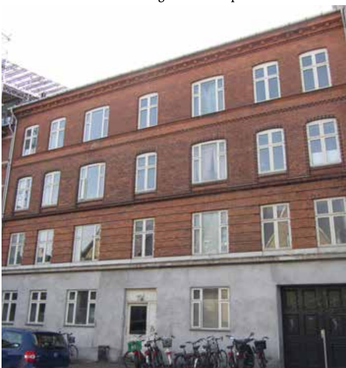
Gesimsbånd er nedslidte og istandsættes Gadefacade mod Landskronagade isoleres på den nederste del
