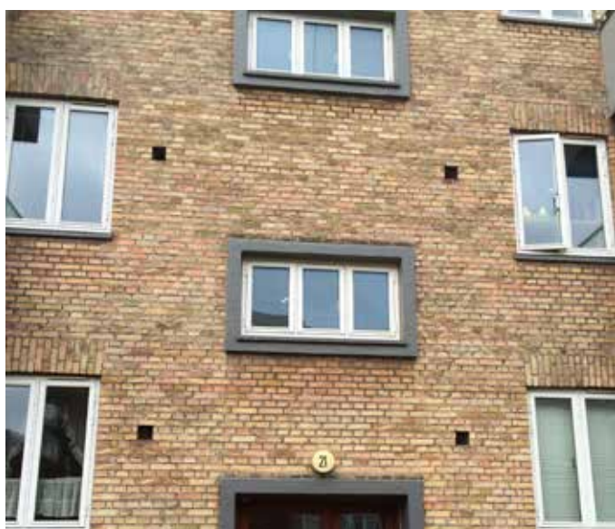
Utætte vinduer udskiftes til støjrducerende vinduer Facade mod Straussvej og Borgmester Chr. vej
