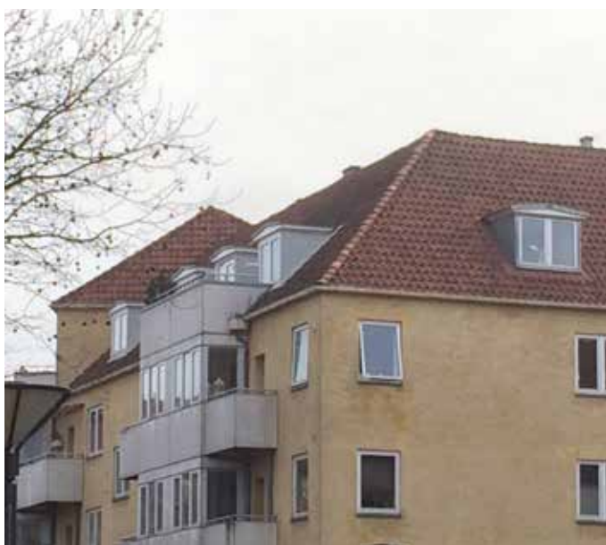
Tag udskiftes og isoleres. Karnapper isoleres udvendigt
