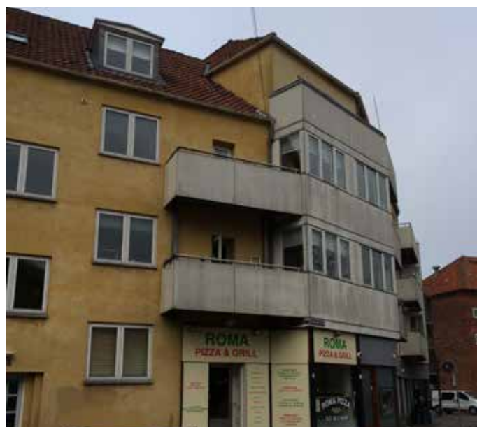
Vinduer udskiftes til støjreducerende energivinduer
