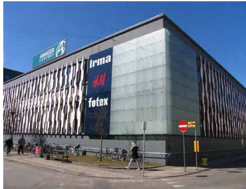
Den nuværende facadearkitektur virker som et fremmed element i Amagers bybillede. Bygningen ligner et indkøbscenter med beliggenhed uden for byen. Den er meget lukket med en stor grå sokkel, der hvor bygningen møder gadelivet. Dette giver bygningen en borg-lignende karakter, som ikke inviterer folk ind.
