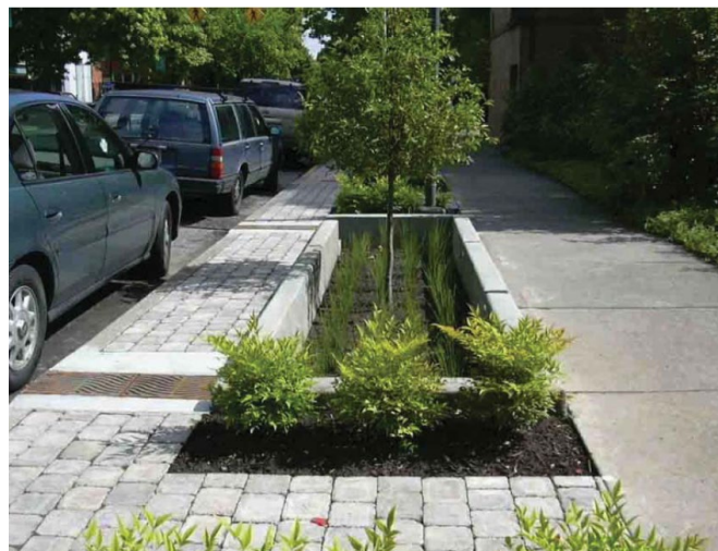
Regnvandsopsamling i bed i urban udformning
