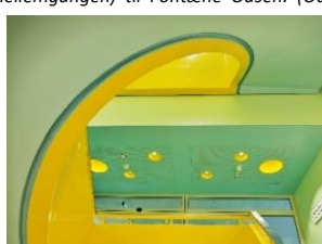
EFTER: Lysinstallationer i loftet.
