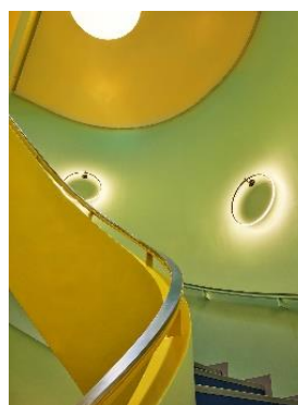
EFTER: Set nedefra op mod det runde dagslysvindue.
