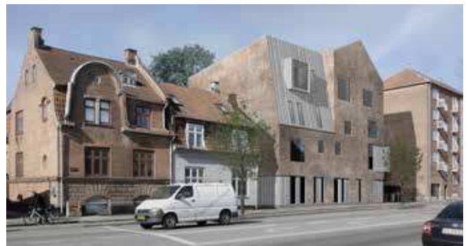
Facade mod Frederikssundsvej (Cornelius + Vøge)
