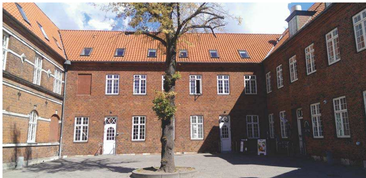
Karens Mindes indre gårdspads, med nuværende hovedindgang inde i hjørnet. Arealet og den tilstødende "gårdspads" kan nemt opgraves og indbyde til ophold.
