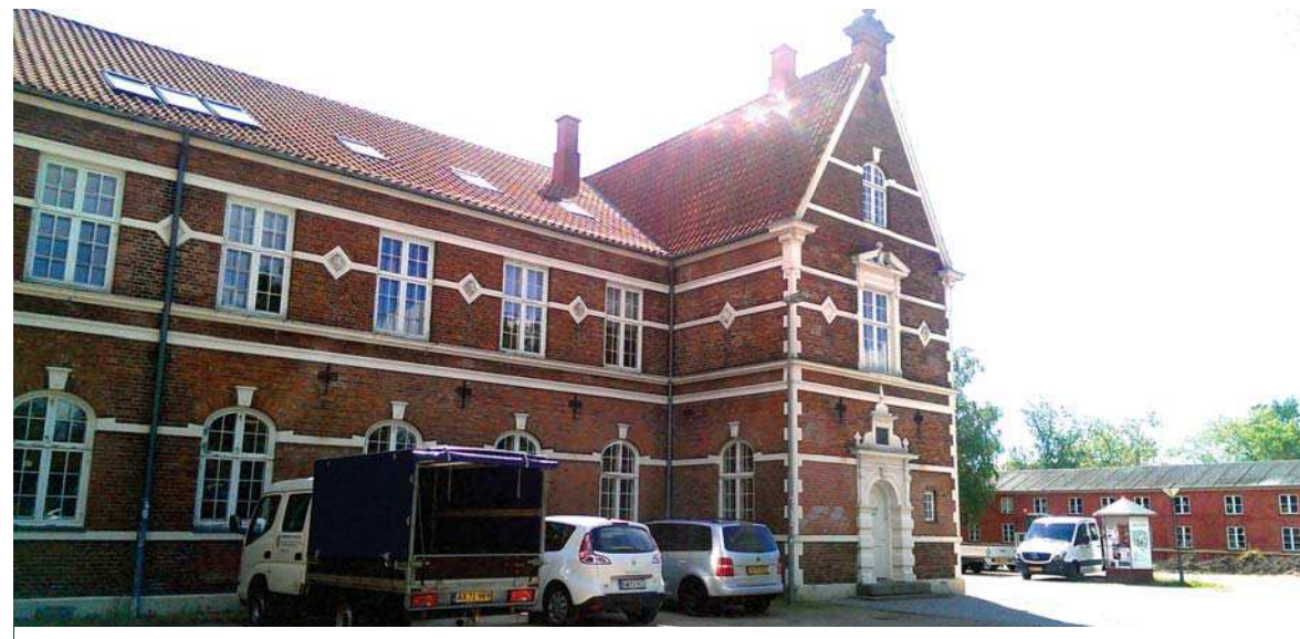
Vestfløjen, som er opført i historicistisk renæssancestil, huser i dag biblioteket i stueetagen. Umiddelbart vest for fløjen er anlagt en grusbelagt parkeringsplads.
