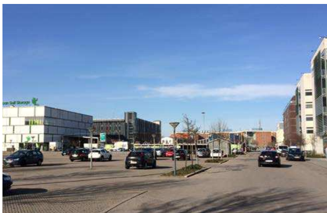
Lokalplanområdet set fra A.C. Meyers Vænge fra syd mod nord med AAU Cph.s gavle til højre i billedet og den store parkeringsplads midt for. Ved siden af AAU Cph. ligger boligbebyggelsen 'Frederikskaj' med 152 lejligheder. Til venstre i billedet langs med Scandiagade ligger 'Pelican Self Storage' samt P-huset.
