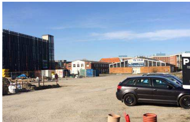
Lokalplanområdet set fra MT-Højgaard's byggegrund fra syd mod nord med p-huset til højre i billedet. P-huset har plads til 659 biler og kan opfylde behovet for parkering i konstruktion i lokalplanområdet samt medvirke til at begrænse parkeringen på terræn. Bagerst i billedet ses 'Hollisen Hallen', der ønskes nedrevet samt 'baghuset' til Teglhølmegade nr. 2 /Scandiagade nr.13.
