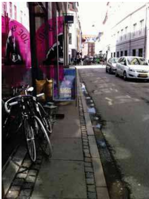
Fodgængere og handicappedes fremkommelighed på fortove er meget ofte ganske begrænset i København, Sværtegade, Indre By, Maj 2011
