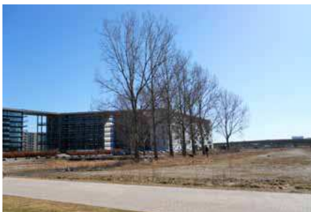
Den sydlige del af "Boligslangen" set hen over byggegrunden.
