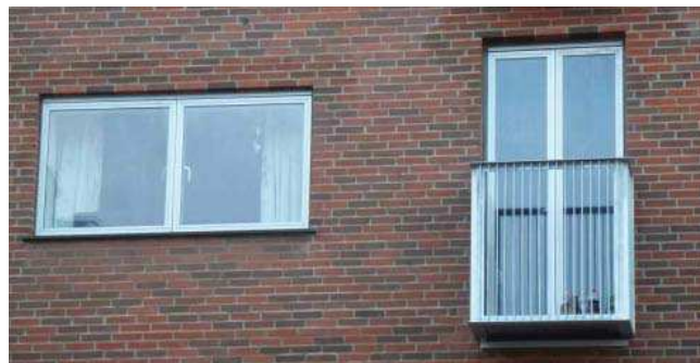
Der er udført en prøve af de nye vinduer og 'spanske altaner'.
