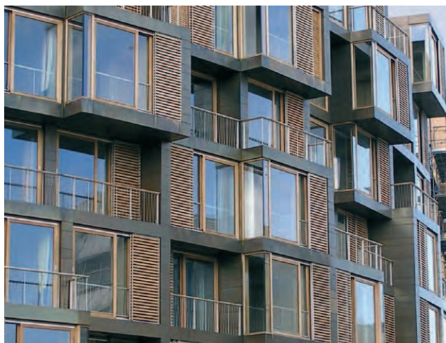
Eksempel på byggeri med stor variation ved udformning af vinduespartier og altaner. (Kilde Københavns Kommune)
