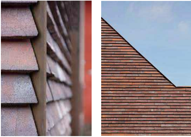
Referencerbilleder: Ophængt tegl med variation i de enkelte sten
