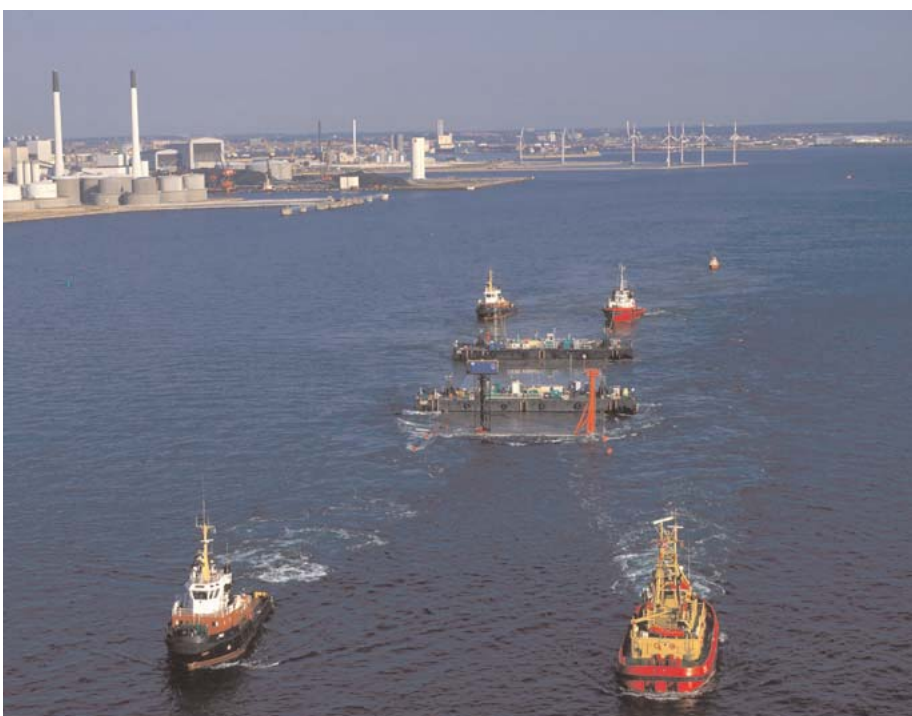
Transport af sænketunnelelement til Øresundsforbindelsen.
