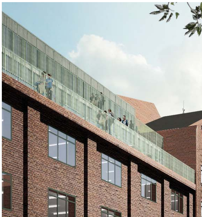
Udsnit af illustration af den foreslåede 4. og 5. etage med tagterrasser mod Bryggernes Plads. Illustration: Adept. Se hele illustrationen på side 8.
