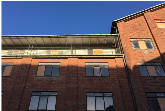
Facaden mod Brygernes Plads med let tagbygning.
