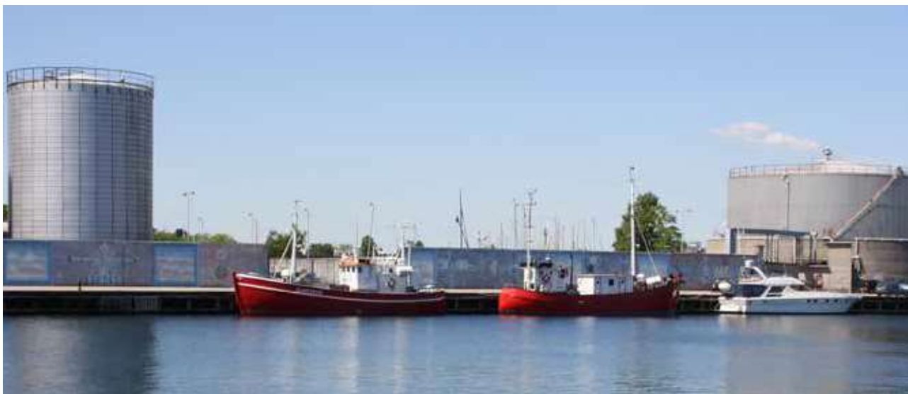
Siloer ved Lautrupskaj foran Svanemølleværket.
