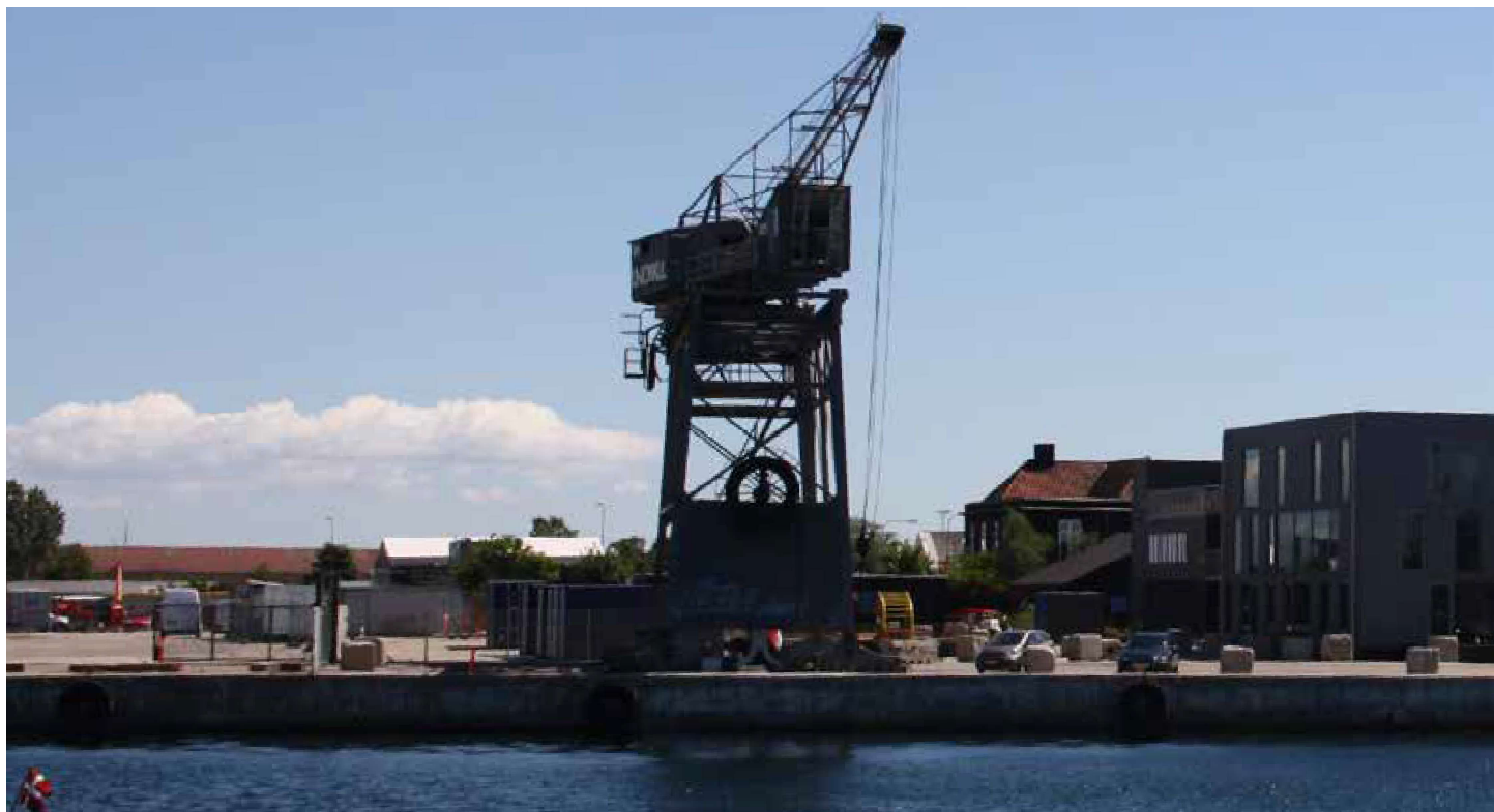
Kalkbrænderiløbskaj på Nordhavn.
