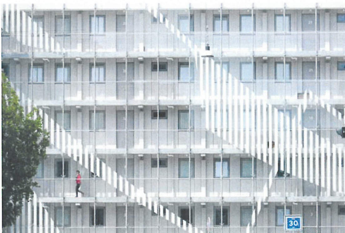
AKB København, afd. Lundtoftegade set fra Lundtoftegade - nye facader af Pålsson Arkitekter
