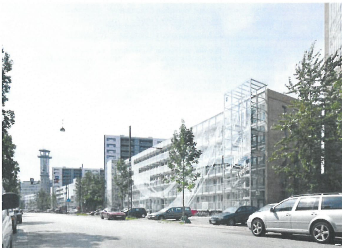
AKB København, afd. Lundtoftegade set fra Lundtoftegade - nye facader af Pålsson Arkitekter
