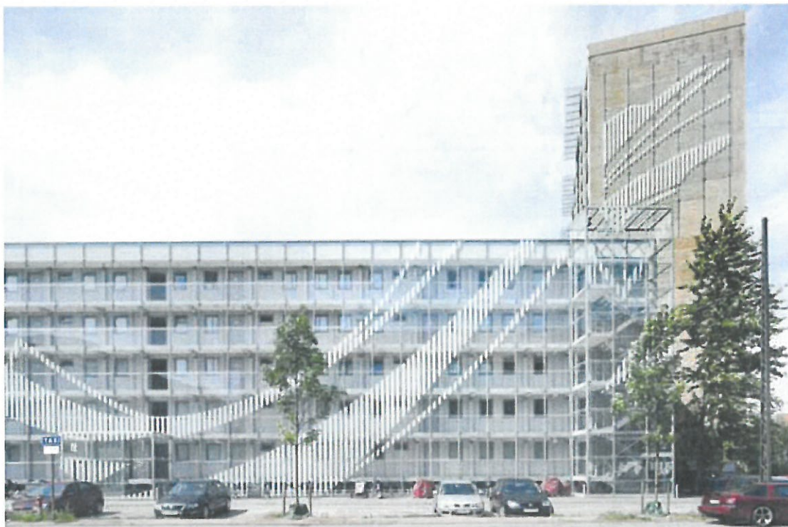
AKB København, afd. Lundtoftegade set fra Lundtoftegade - nye facader af Pålsson Arkitekter
