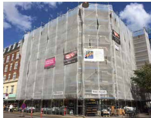
Helhedsrenovering. Foto TMF
