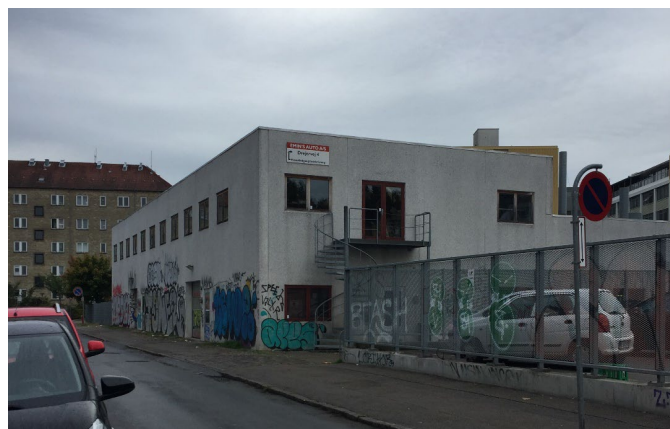
Drejervej 4, set fra Rebslagervej Her opføres nybyggeri.
