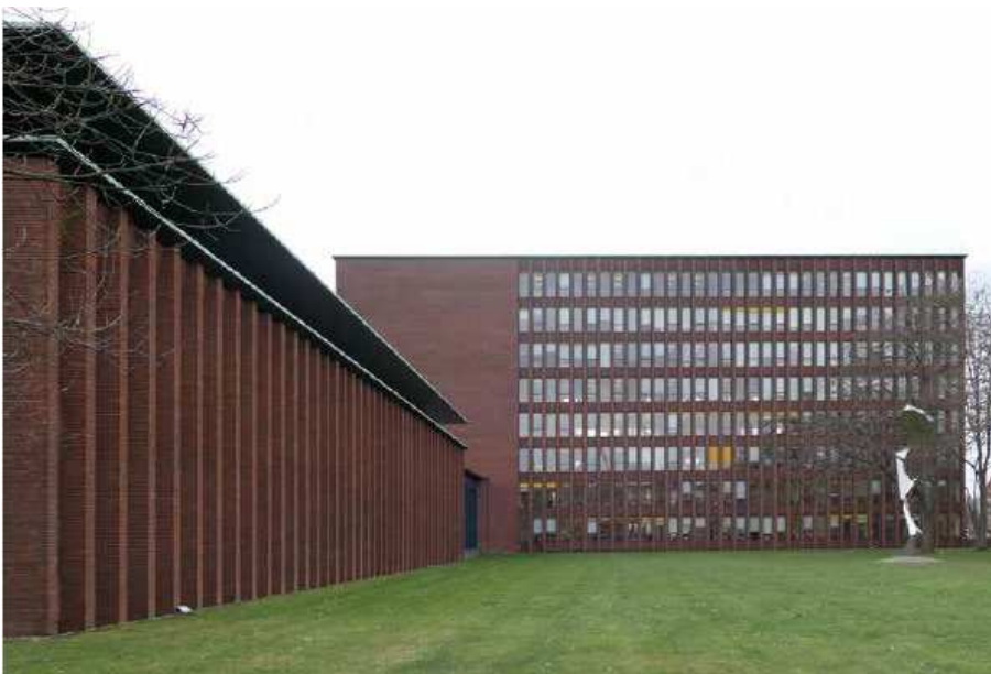
FLSmidths hovedsæde set fra plænen mod Vigerslev Allé. Bygningen i 8 etager bevares, mens den lave bygning erstattes af en ny bygning i 8-9 etager.
