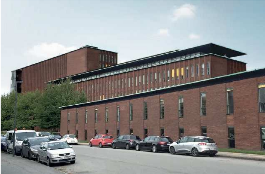
FLSmidths hovedsæde set fra Ramsingsvej. De to højeste bygninger bevares. Den lave laboratoriebygning, forudsættes nedrevet og erstattet med boligbebyggelse i tre etager.
