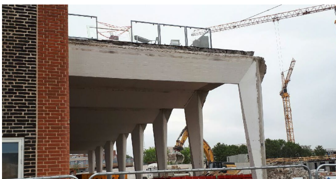
Lindgreens Allé 12, bevaringsværdige bygningskonstruktioner
