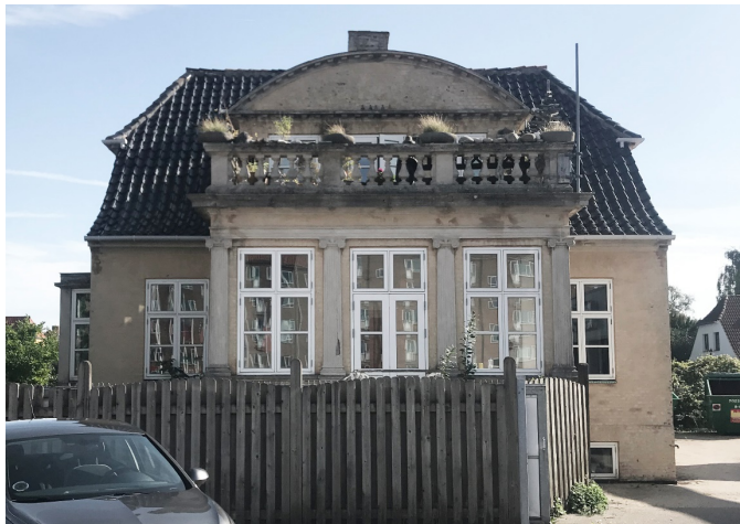
Den eksisterende bygning på Ulrik Birchs Allé 47 set fra lokalplanområdet. Bygningen er en herskabsvilla fra 1921 og udpeges som bevaringsværdig.
