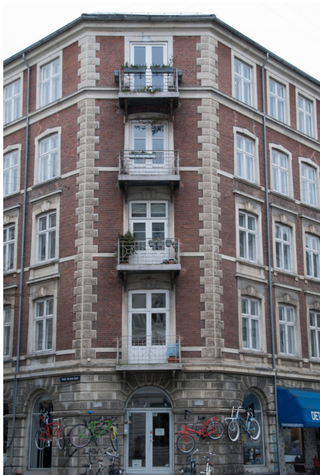
Foto 22. Eksempel på nye altandørpartier, hvor der ikke er blevet koordineret mellem de forskellige boliger, så alle dørpartierne har fået forskellige udtryk.
