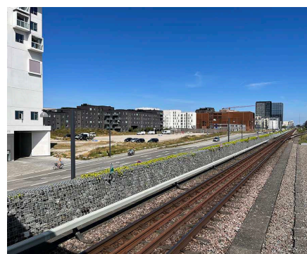
Byggegrund ved Ørestads Boulevard set fra Vestamager Metrostation.
