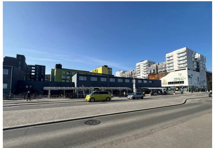
Byggegrund mod Ørestads Boulevard på hjørnet ved Asger Jorns Allé. Anvendes midlertidigt til skolepavilloner.
