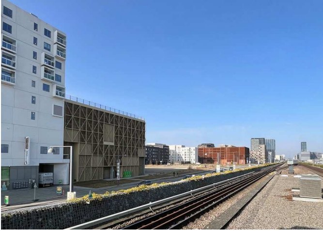
Byggegrund ved Ørestads Boulevard set fra Vestamager Metrostation.
