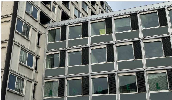
Foto kontorbygningen fra Jagtvej
