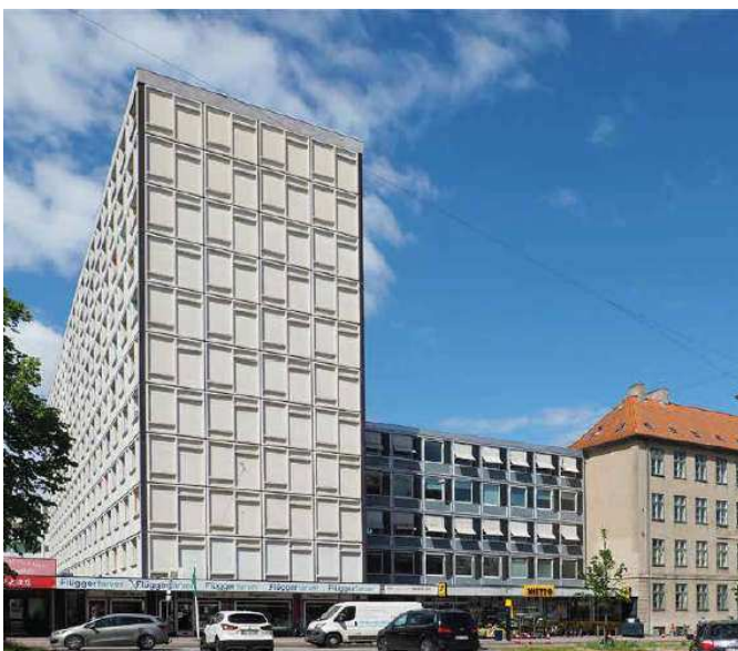
Foto højhuset og kontorbygningen fra Jagtvej
