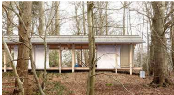
Houens Odde Spejdercenter, Pihlmann (konkurrenceforslag) Et eksisterende punktfundament, som de nye bygninger bygger ovenpå. Det løftede greb skaber en lethed og lader huset fremstå svævende. Houens Odde Spejdercenter, pihlmann (konkurrenceforslag).
