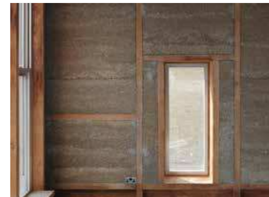
Timber Weaver's studio, Practice Architecute, London, er bygget i biogene materialer som træ og hempcrete. Bygningen er designet, så det ikke krævede særlige kompetencer at udføre det.
