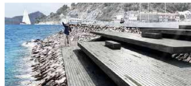
Reference – På kanten Træplateauer indsat i stensætning og danner overgang til vandoverfladen
