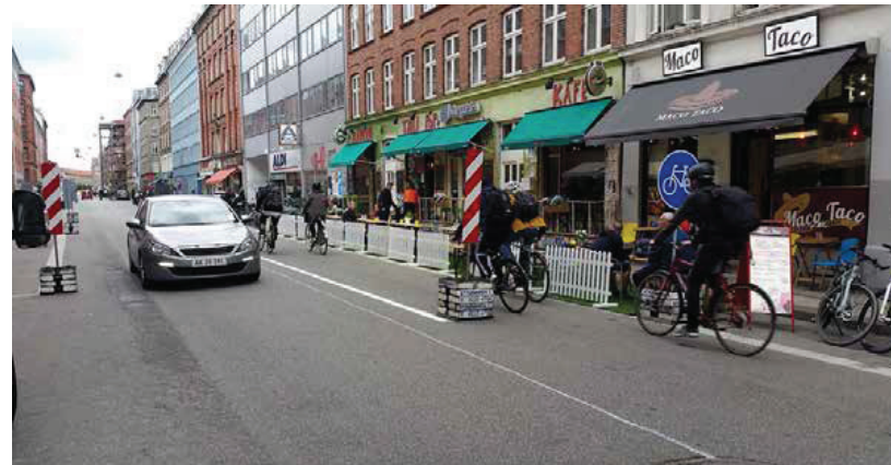
Vejjindsnævring skaber mulighed for cykelsti i begge retninger, samt flexområde i den ene side
