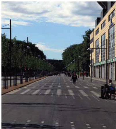
Vejbemaling i termoplast markerer blød trafik og tværgående trafik langs Parken på Øster Allé
