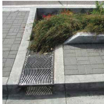
Grøn regnvandsforsinkelse langs gade i Portland, USA
