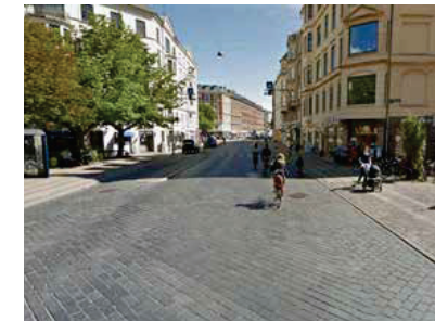
Hævet kørebane med materialeskift langs Victor Borges Plads på Nordre Frihavnsgade som fartdæmpende foranstaltning
