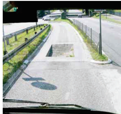
Bussluse med grav og opkørselsrampe på Avedøre Havnevej ved Rødovre station
