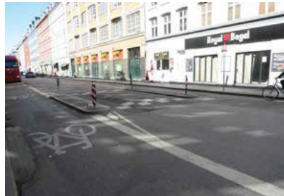
Vejbump på Rantzausgade har skabt lokal utryghed
