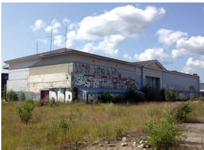
'Specialstålhallen' set fra Vasbygade. Foto: DesignGroup Architects
