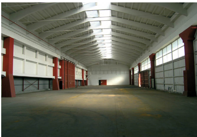
'Specialstålhallen' indvendig. Foto: DesignGroup Architects
