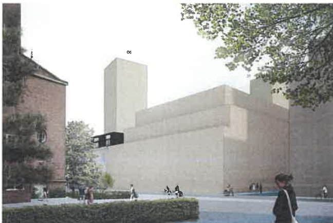
Ny tilbygning (th.) til Mineralvandsfabrikken (i midten) set fra Francisca Clausens Plads ved Kraftværket (tv.). Bygningens nederste del flugter i højden med Mineralvandsfabrikkens pudsede facade. De øverste to etager er trukket tilbage, så Mineralvandsfabrikken kan opleves med de karakteristiske sorte tagetager, og ikke overtrumfes af den ny bebyggelse.
