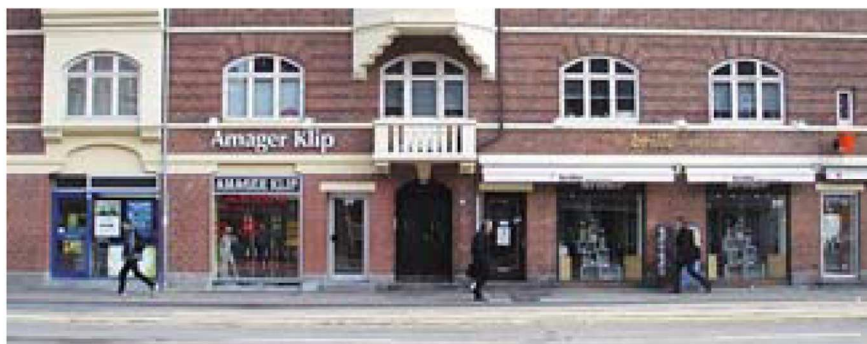
Butikker med udstillingsvinduer mod Amagerbrogade. Butikfacader og skiltning respekterer bebyggelsens arkitektur.
