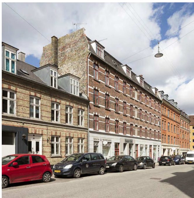
Eksisterende forhold - facade mod Gammel Jernbanevej. Foto: Torben Eskerod.
