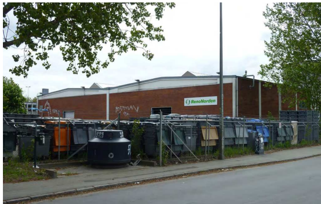
Bygningen set fra Raffinaderivej
