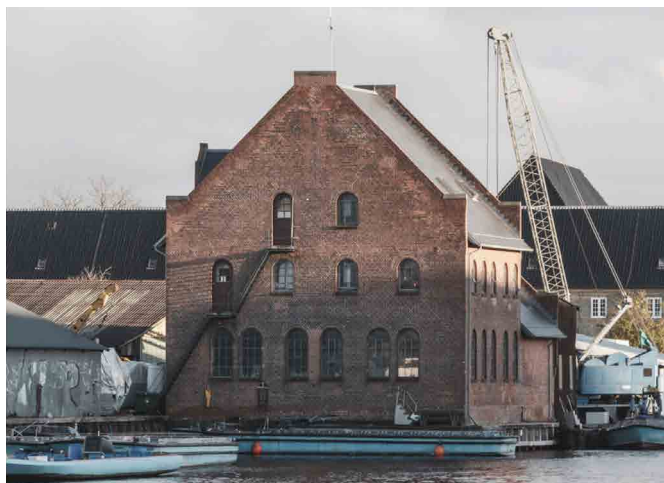
Materiel- og kedelhuset, som har bevaringsværdi 3. Foto: COBE.
