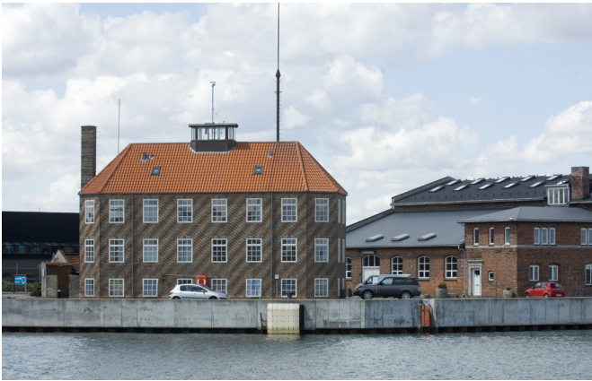
Lodsbbygningen 'Lodseriet' er opført i 1942 som Lods- og Karantænestation.
