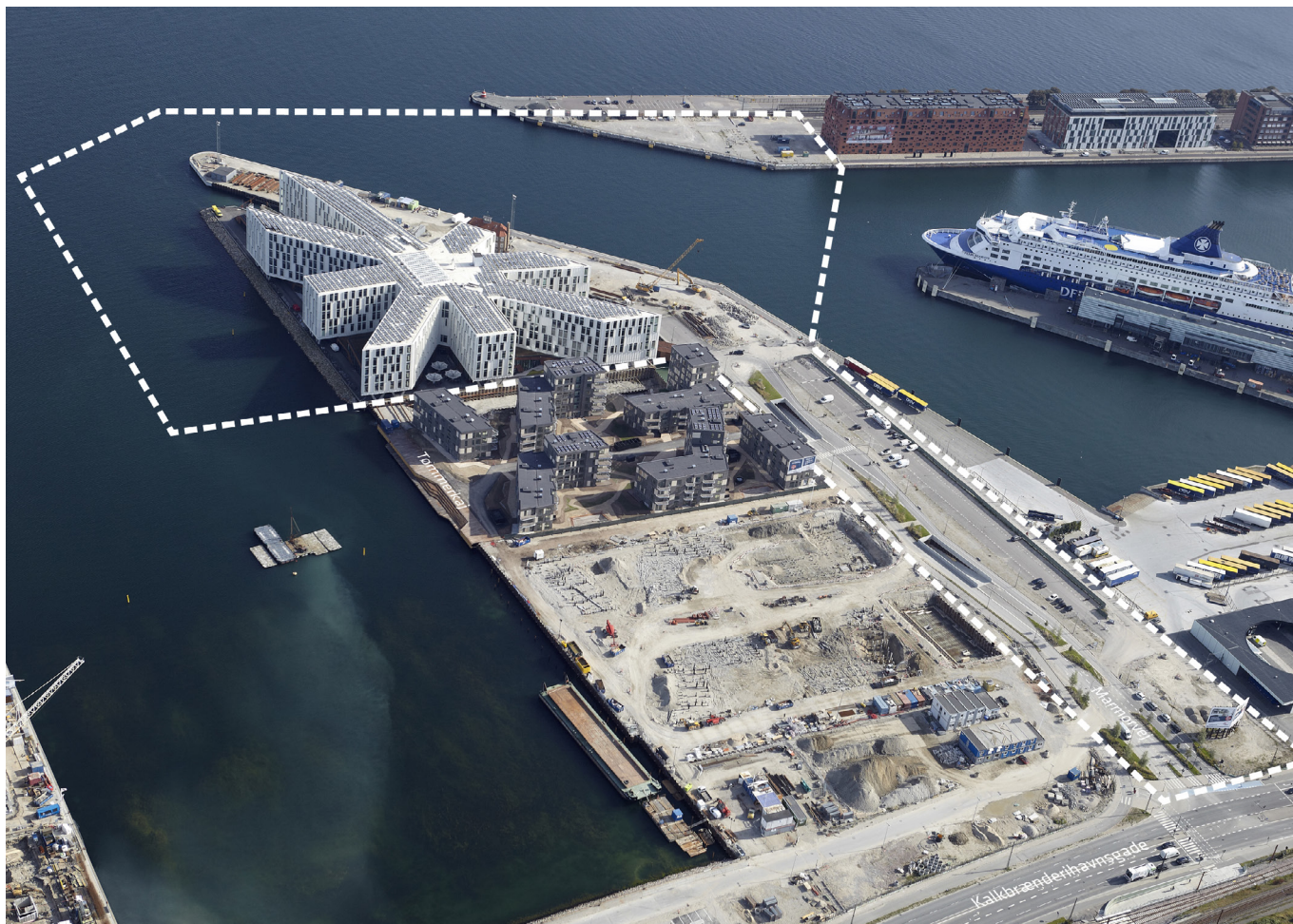
Området for tillæg nr. 1 til lokalplan nr. 440 Marmormolen II er vist med hvid, stiplede linje. JW Luftfoto, oktober 2015.
