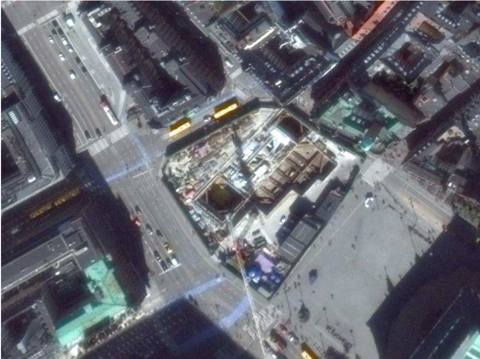
Figur 3-12 Udgravning til metrostation ved Rådhuspladsen
