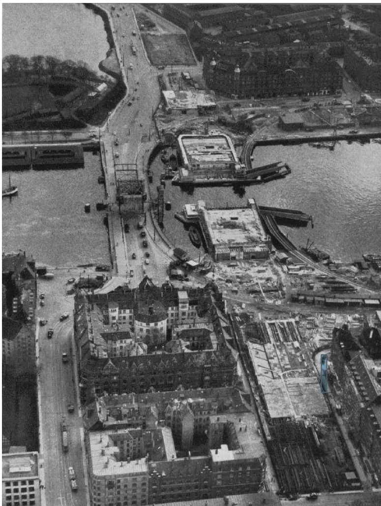
Figur 3-13 Anlæg af ny Langebro i 1953 set fra vest mod øst. Her ses Interimsbro, ny Hovedbro og jernbanebro. [4]
