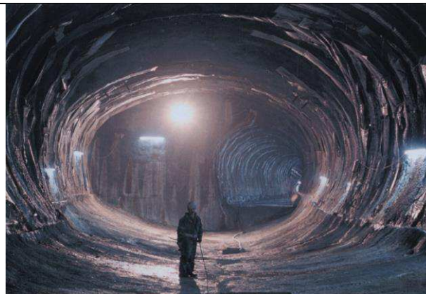
Figur 7-23 17 m bredt afgreningskammer i Københavns metro
