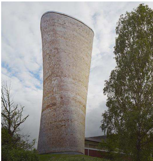
Figur 7-36 Ventilationstårn med udvendig træbeklædning (beton indvendig), Norra Länken, Sverige
