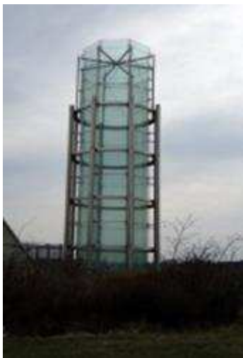
Figur 7-35 Ventilationstårn i glas, Södra Länken Stockholm, Sverige
