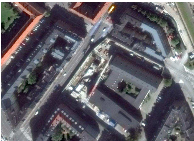
Figur 3-4 Udgravning til metrostation ved Nuucs Plads
