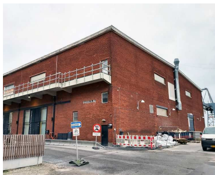
Bevaringsværdig bygning – Pakhus 53.
