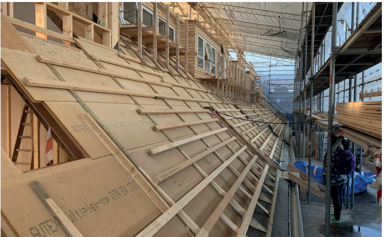
↓ Renovering af Fredens Arks tag, foto Københavns Kommune
