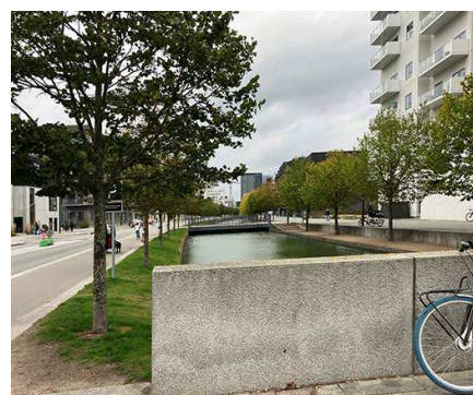
Byrummet Kanalrummet (Robert Jacobsens Vej) set fra Asger Jorns Allé mod nord.
