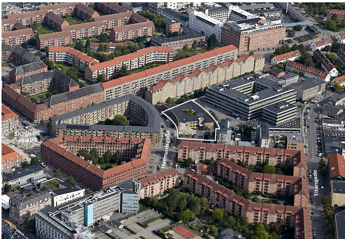
Lokalplanområdet Hermodsgade 26-28 (hvh. matr.nr. 5681 og 5595, Udenbys Klædebo Kvarter) ligger i et kvarter med boliger, erhverv og uddannelsesinstitutioner. Skråfoto af lokalplanområdet set mod nord. Foto: JW Luftfoto, august 2019.
