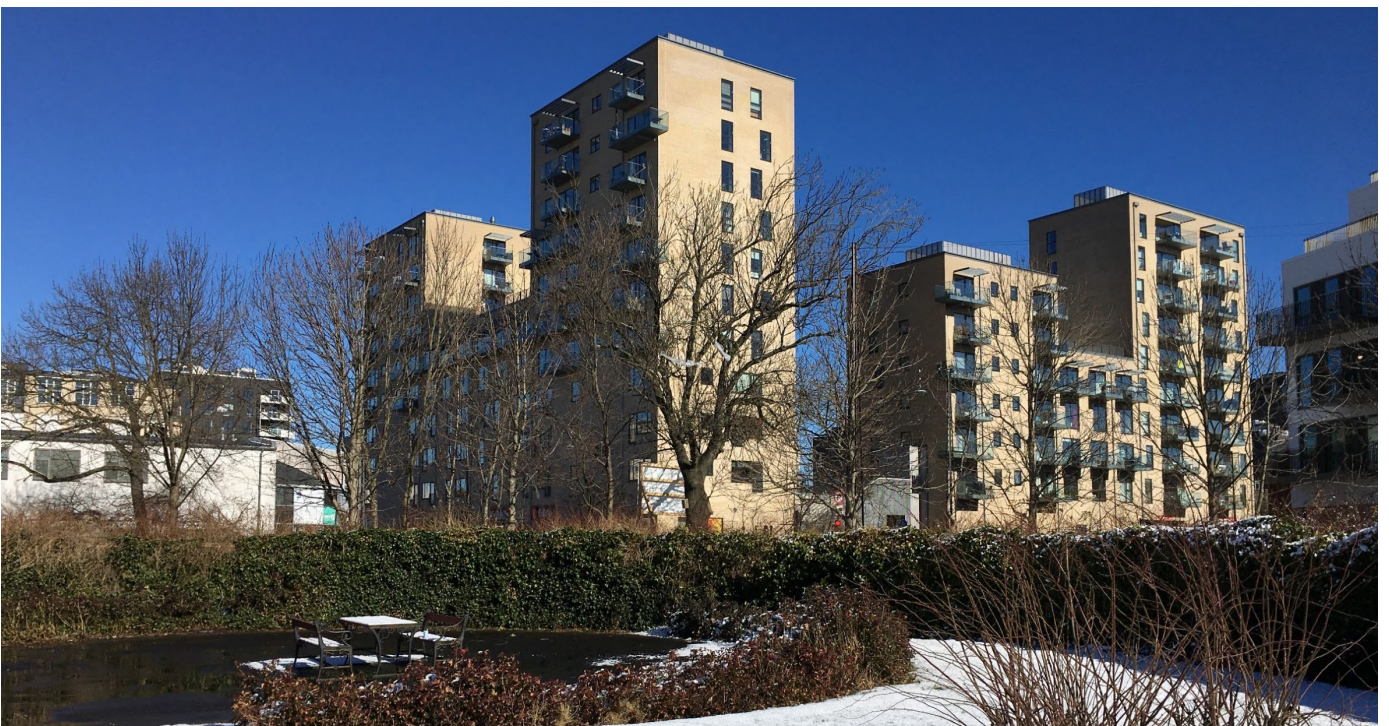
Haveanlægget Karolinehaven set mod hjørnet af Lergravsvej og Strandlodsvej, hvor plejecentret skal placeres.
