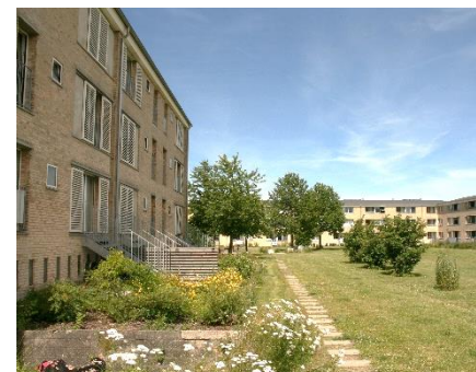
Haverum ved Bygårdstræde set mod nord
