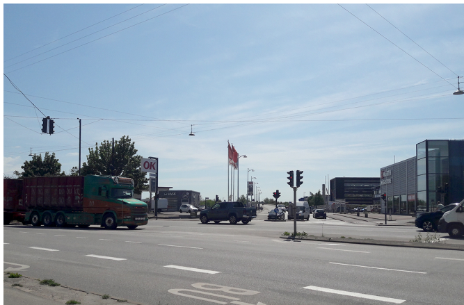
Bådehavnsgade set fra Sjællandsbroen.
